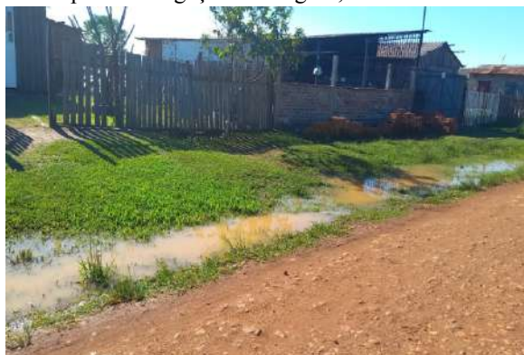
Figura 07: Escoamento pluvial e ligações de esgoto, vila Arneldo Matter, bairro do passo.
