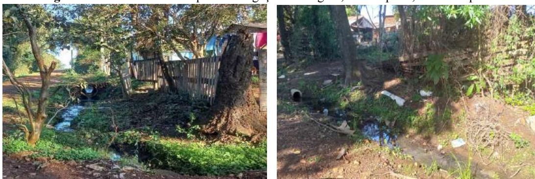
Figura 05 e 06: Escoamento pluvial e ligações de esgoto, vila da paria, bairro do passo.
