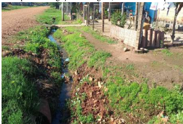
Figura 08: Escoamento pluvial e ligações de esgoto, vila Mario Roque Weis, bairro do passo.
