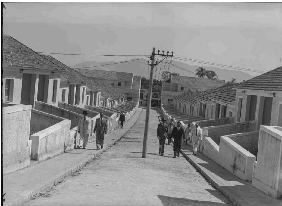
Vistas de uma vila de casas em Marechal Hermes, Rio de Janeiro, RJ. Ano: 09/05/1947.
