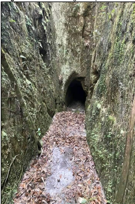
Figura 01: Canal dos ingleses: parte interna.
