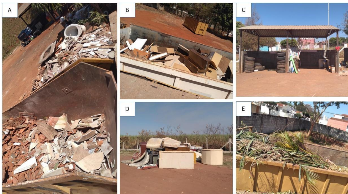
Figura 02: Mosaico de organização interna dos PEVs: (A) Resíduos de construção civil depositados em caçambas, (B) Resíduos de madeira dispostos em caçamba, (C) Área coberta onde são separados pneus e lâmpadas fluorescentes, (D) Resíduos volumosos segregados dos demais, (E) Resíduos de podas colocados em caçamba.
